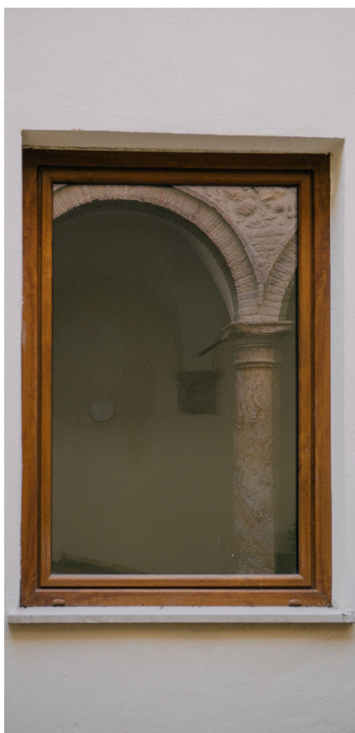
Immagini fotografiche di dettaglio dell'intervento di restauro dell'edificio Palazzaccio del comune di Tolfa
